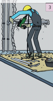
2.2 Trinkwasserleitungen nach Absprache demontieren 3
